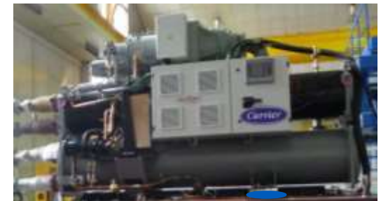
Remplacement des groupes frigorifiques par des machines plus puissantes
