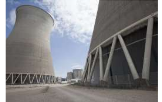
Rénovation des corps d'échanges des aéroréfrigérants
